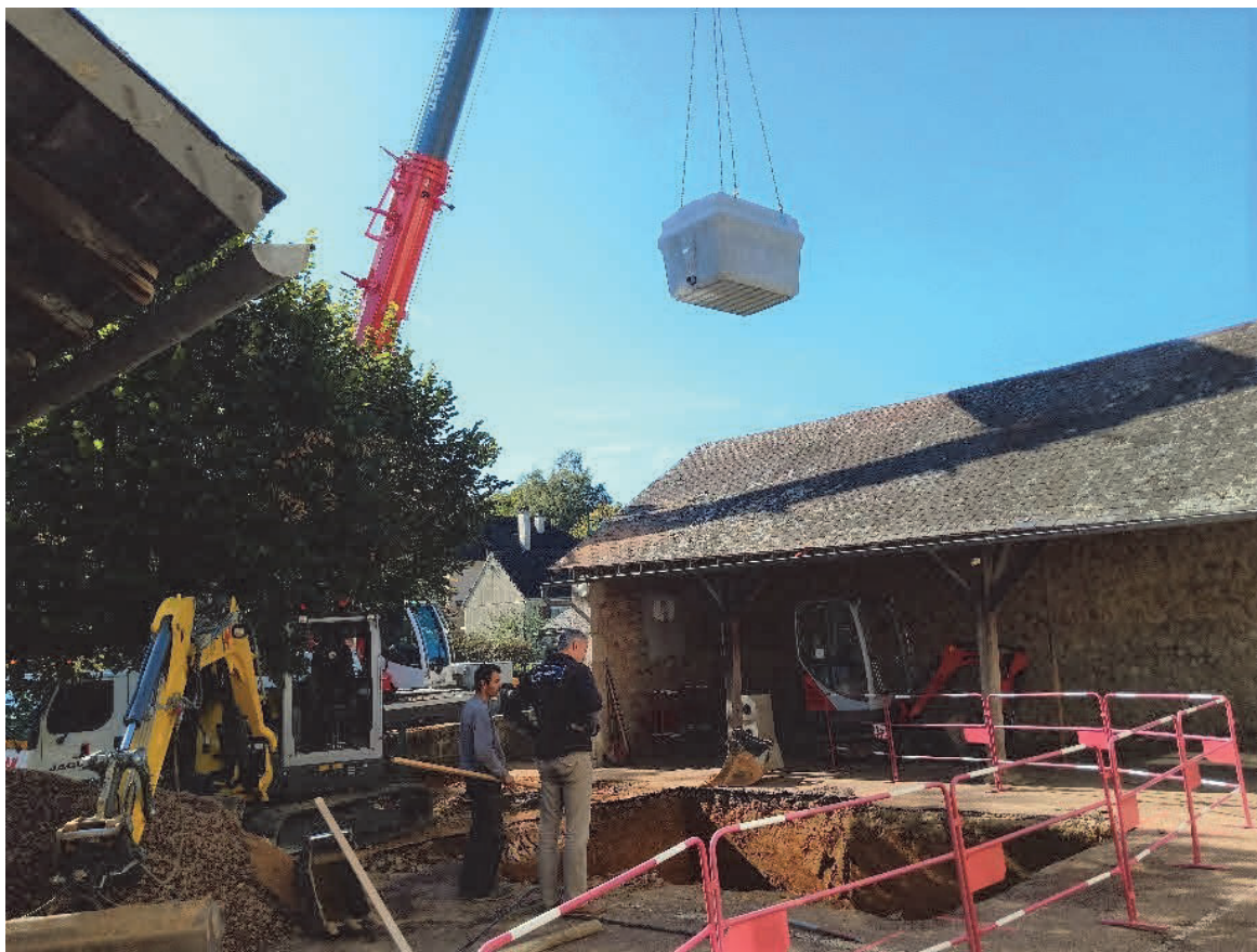
Réalisation de l'assainissement de l'école de Brassy en octobre 2019 par l'entreprise Meugnot de Moux-en-Morvan.
